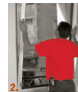
2. Installazione del nuovo serramento.
