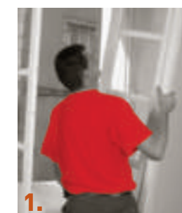
1. Rimozione delle ante.
